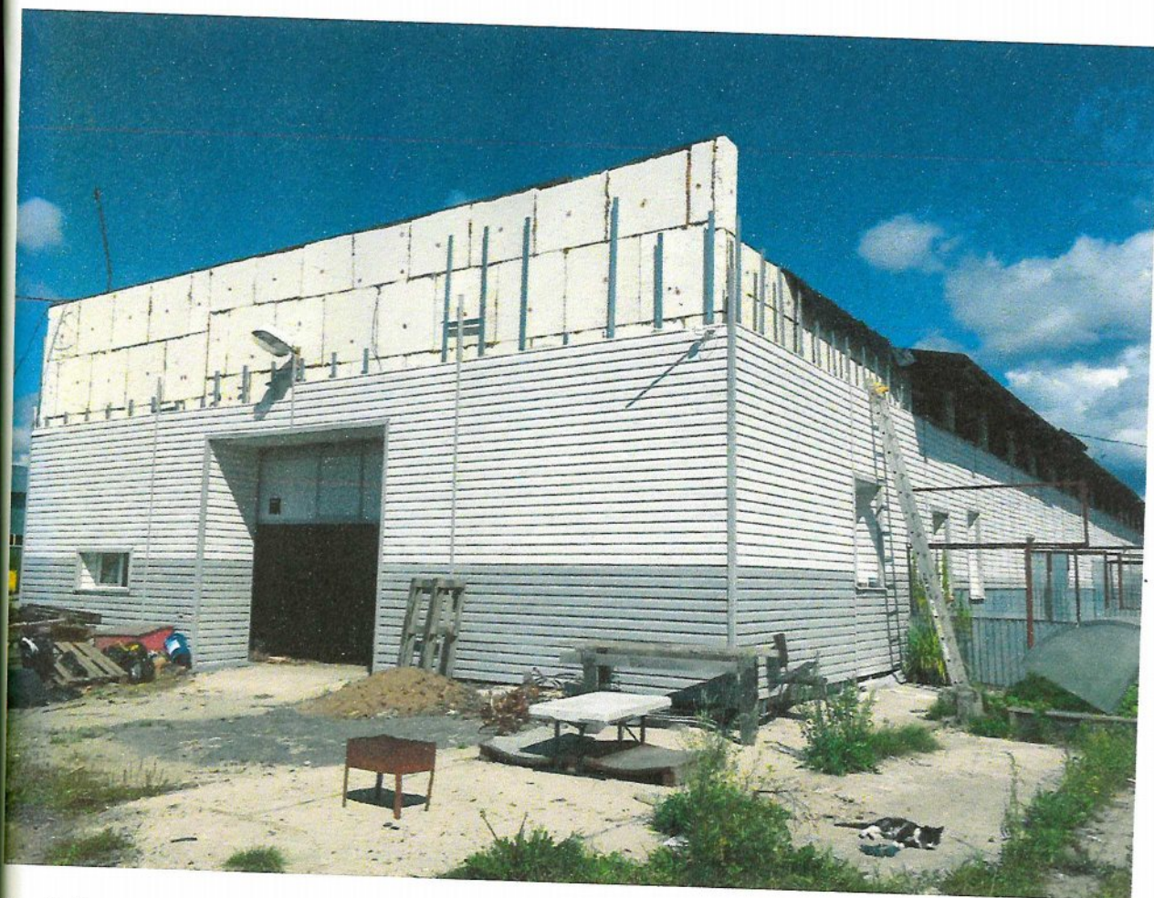
Фото 8. Одноэтажное кирпичного здания склада
