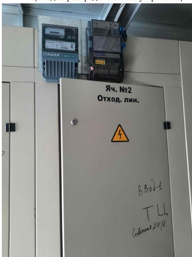
Счетчик электроэнергии 5-7,5А Меркурий 230 Счетчик электроэнергии 5-10А Меркурий 234
