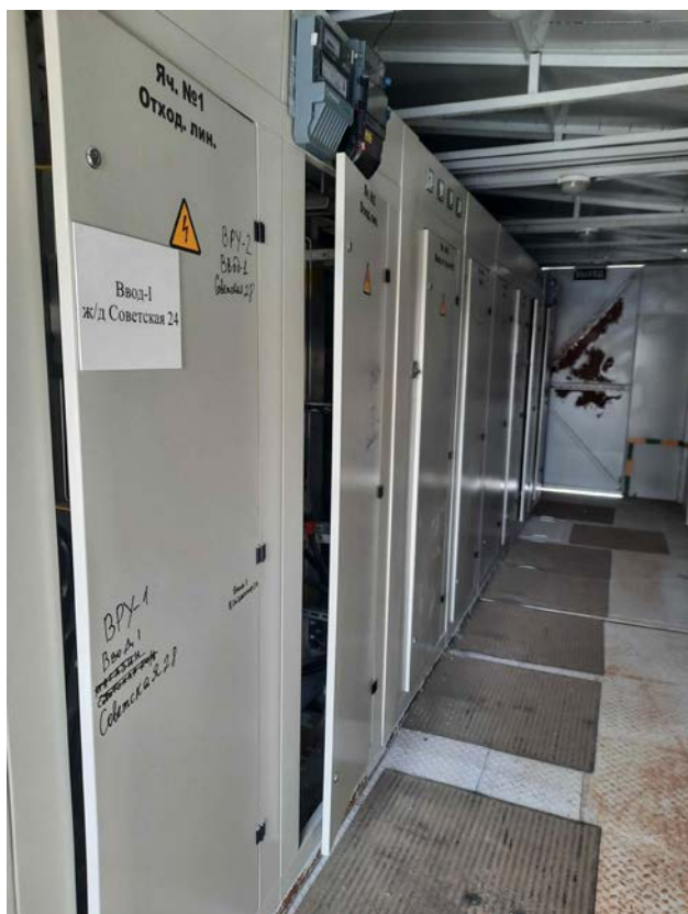
ВРУ (Вводно-распределительное устройство)
