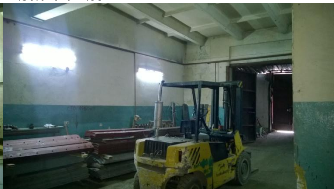
Фото 20. Нежилое помещение, кадастровый номер 74:36:0404014:98
