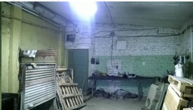
Фото 14. Нежилое помещение, кадастровый номер 74:36:0404014:98
