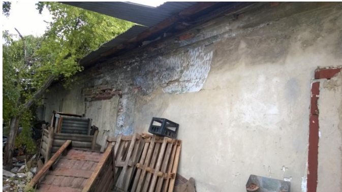
Фото 29. Нежилое помещение, кадастровый номер 74:36:0404014:98
