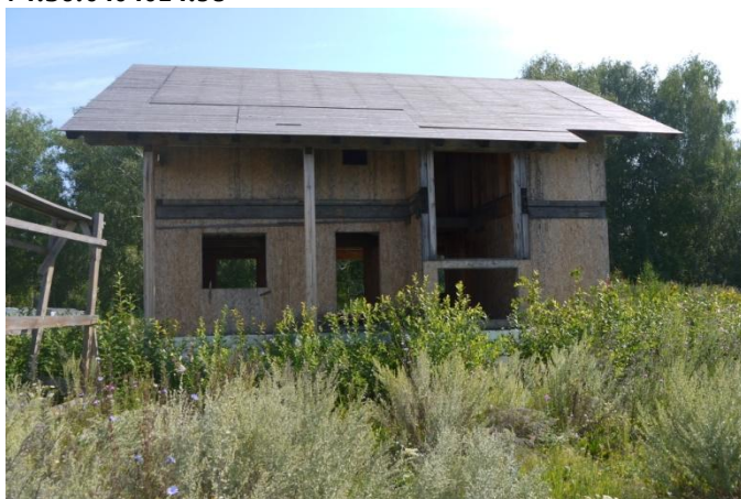
Фото 43. Объект незавершенного строительства, кадастровый номер 74:19:1107001:2956
