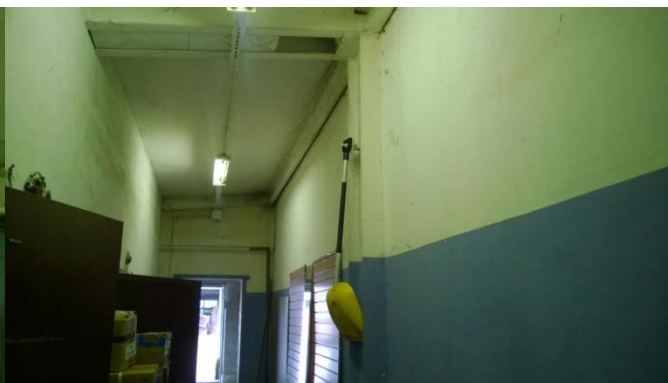
Фото 42. Нежилое помещение, кадастровый номер 74:36:0404014:98
