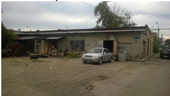
Фото 1. Нежилое помещение, кадастровый номер 74:36:0404014:98
