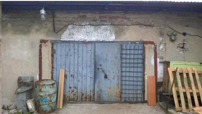
Фото 30. Нежилое помещение, кадастровый номер 74:36:0404014:98
