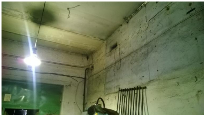
Фото 13. Нежилое помещение, кадастровый номер 74:36:0404014:98
