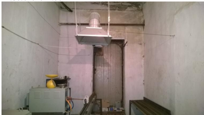
Фото 21. Нежилое помещение, кадастровый номер 74:36:0404014:98
