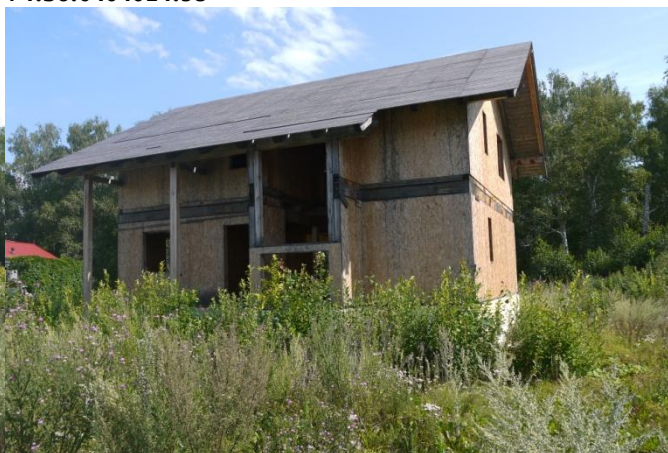
Фото 44. Объект незавершенного строительства, кадастровый номер 74:19:1107001:2956
