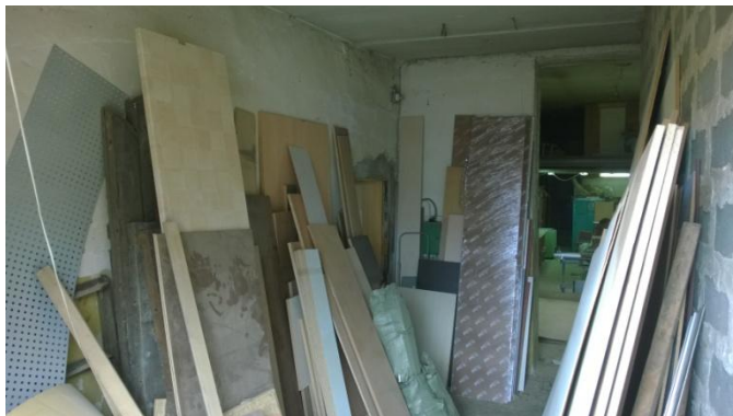
Фото 3. Нежилое помещение, кадастровый номер 74:36:0404014:98
