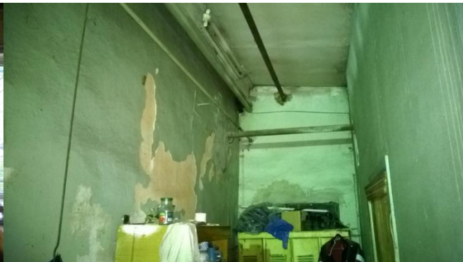
Фото 28. Нежилое помещение, кадастровый номер 74:36:0404014:98
