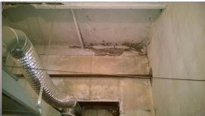
Фото 22. Нежилое помещение, кадастровый номер 74:36:0404014:98
