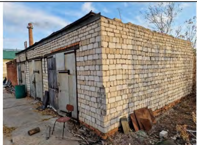
Фото 2. Нежилое здание (гараж кирпичный на 4 бокса)
