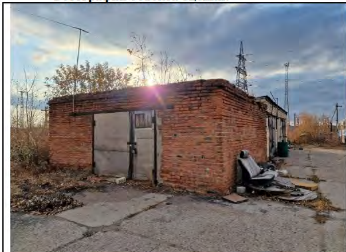
Фото 1. Нежилое здание (гараж кирпичный на 4 бокса)
