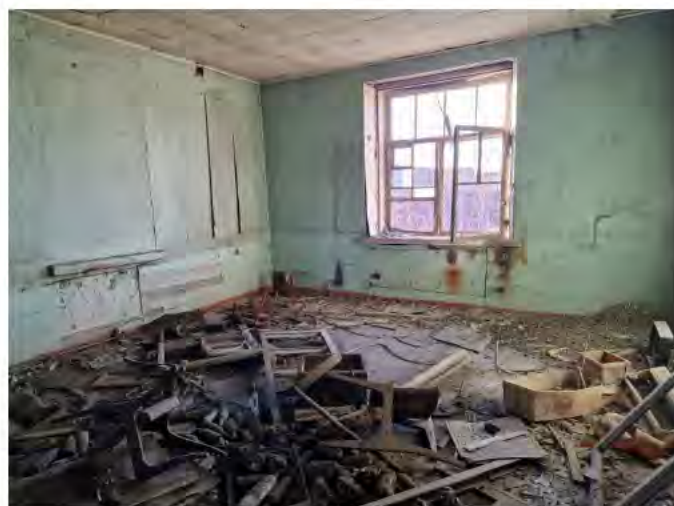
Фото 20. Нежилое здание с кадастровым номером 22:71:010416:33
