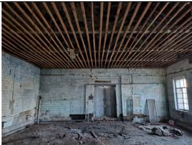
Фото 13. Нежилое здание с кадастровым номером 22:71:010416:33
