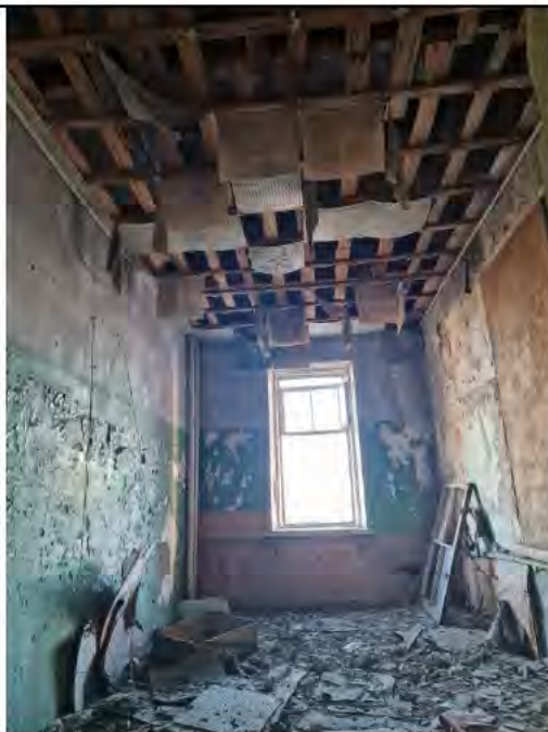
Фото 19. Нежилое здание с кадастровым номером 22:71:010416:33
