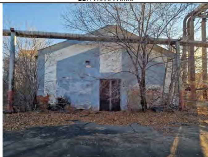
Фото 10. Нежилое здание с кадастровым номером 22:71:010416:33
