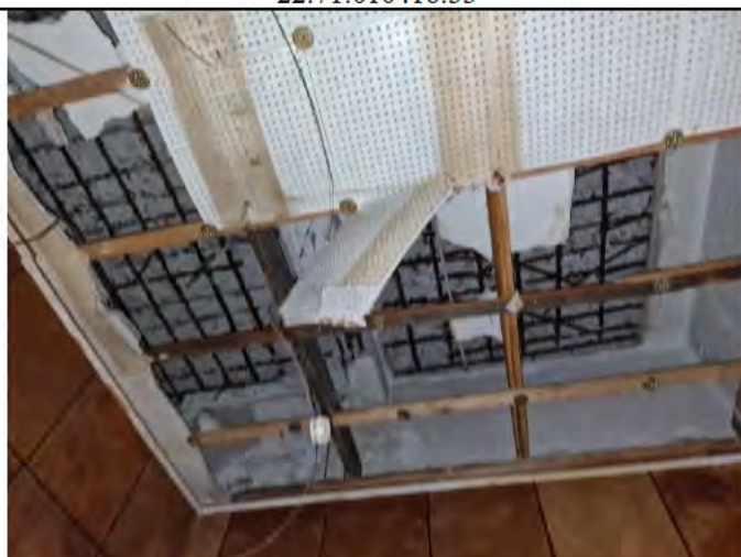
Фото 18. Нежилое здание с кадастровым номером 22:71:010416:33
