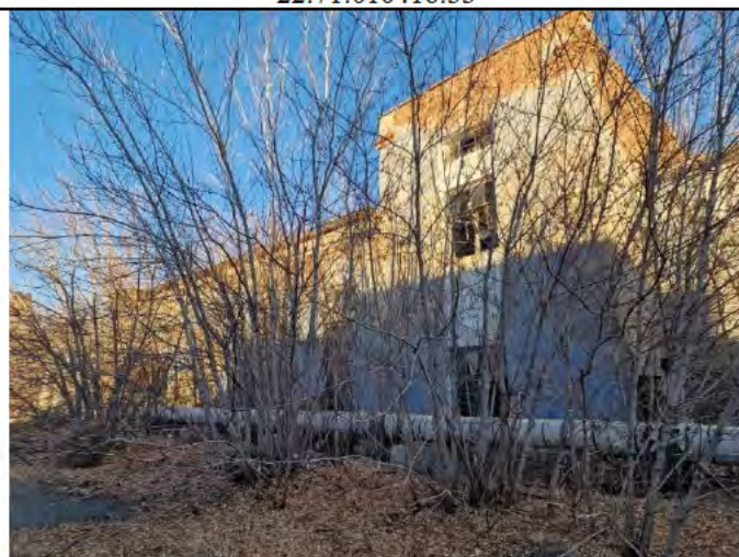
Фото 12. Нежилое здание с кадастровым номером 22:71:010416:33
