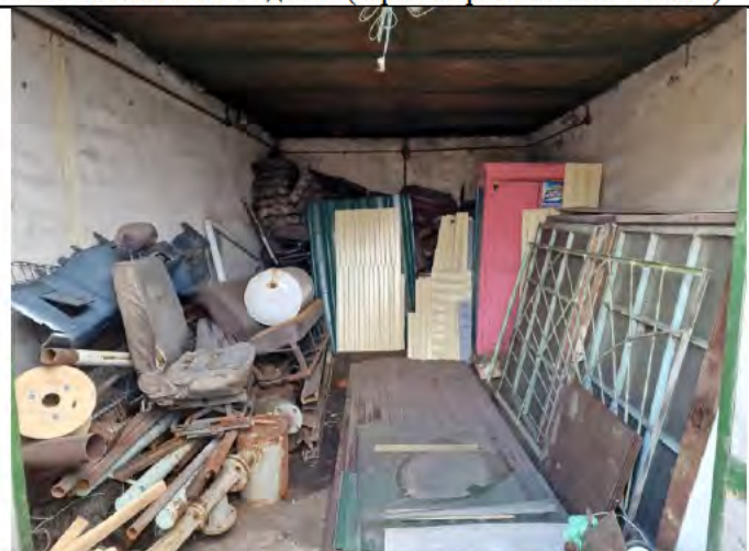
Фото 6. Нежилое здание (гараж кирпичный на 4 бокса)
