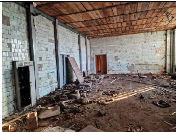
Фото 14. Нежилое здание с кадастровым номером 22:71:010416:33
