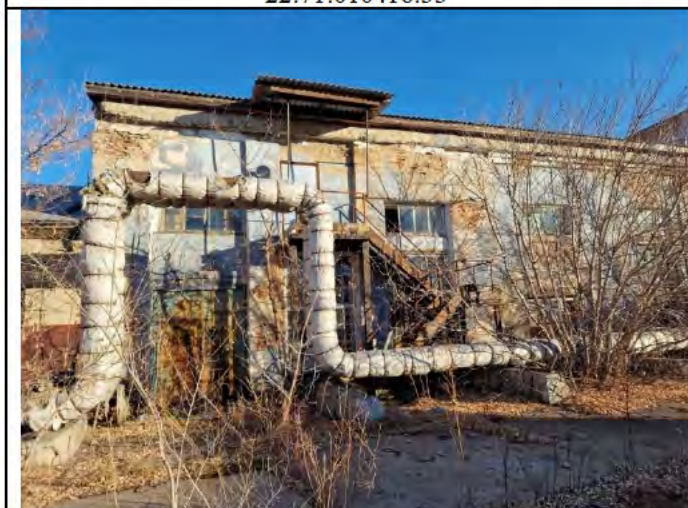
Фото 11. Нежилое здание с кадастровым номером 22:71:010416:33
