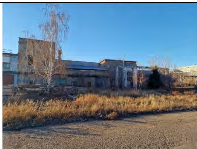
Фото 8. Нежилое здание с кадастровым номером 22:71:010416:33
