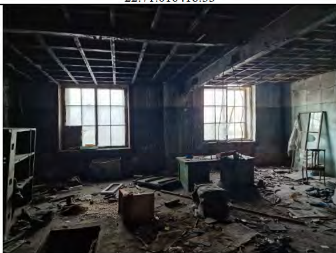
Фото 15. Нежилое здание с кадастровым номером 22:71:010416:33
