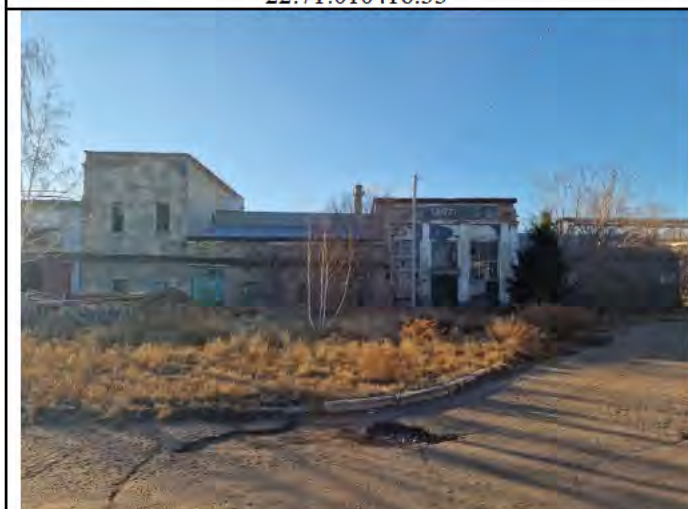
Фото 9. Нежилое здание с кадастровым номером 22:71:010416:33
