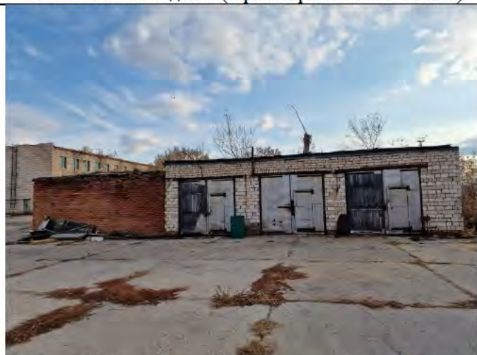
Фото 5. Нежилое здание (гараж кирпичный на 4 бокса)
