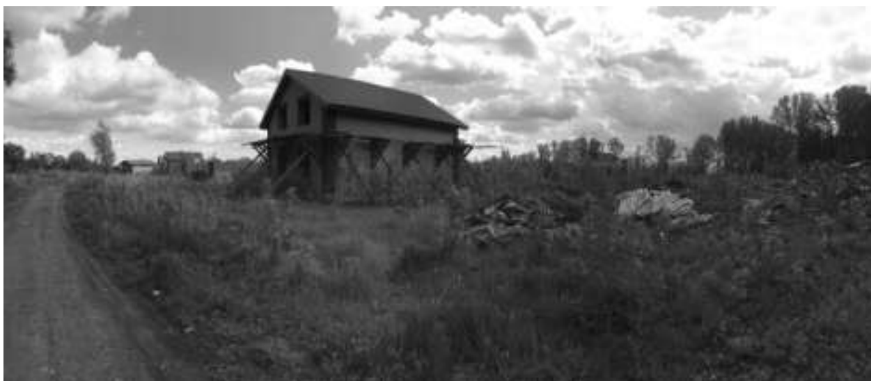
Изображение 5. Объект оценки (Общий вид незавершенного строительстве туристического центра)
