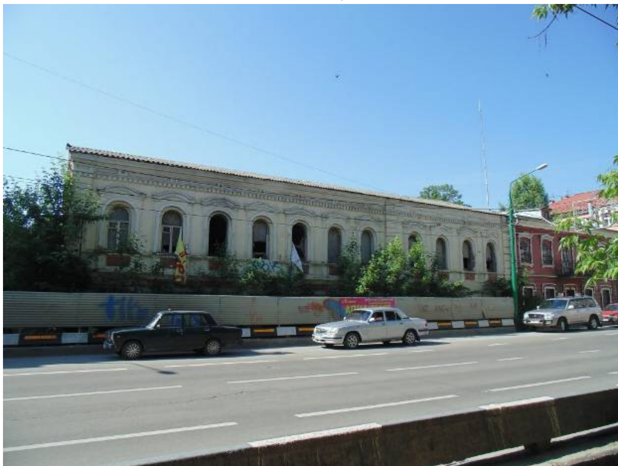
Рисунок 5.7. Объект оценки № 2 (вид фасада с улицы Первомайская, дата фото - не известна)
