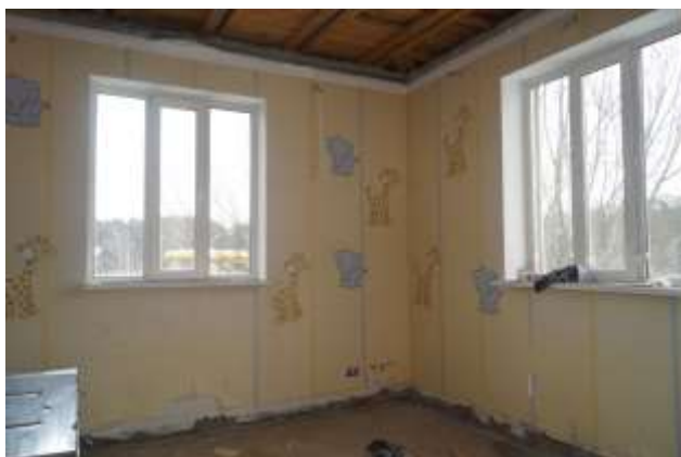
фотография №21 Жилая (№12 на поэтажном плане 2-го этажа)
