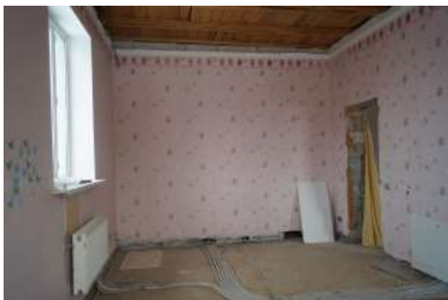
фотография №25 Жилая (№9 на поэтажном плане 2-го этажа)
