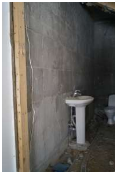
фотография №17 Санузел (№7 на поэтажном плане 1-го этажа)
