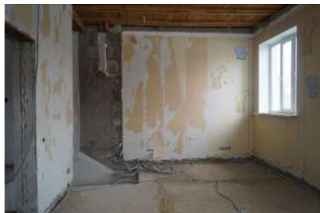
фотография №23 Жилая (№12 на поэтажном плане 2-го этажа)
