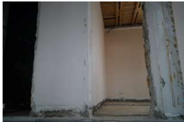
фотография №22 Жилая (№12 на поэтажном плане 2-го этажа)
