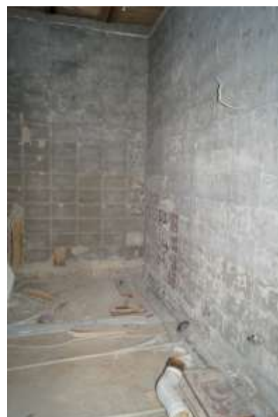
фотография №27 Санузел (№10 на поэтажном плане 2-го этажа)
