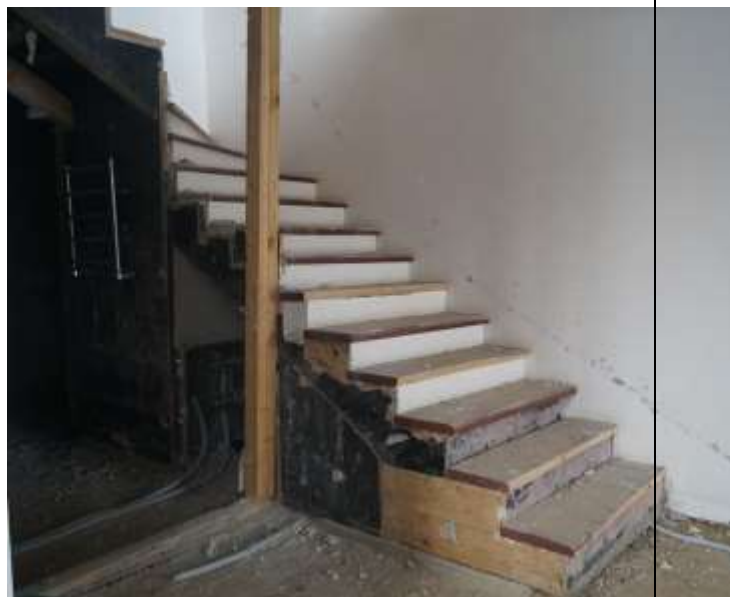
фотография №15 Коридор (№2 на поэтажном плане 1-го этажа)
