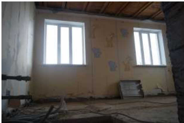
фотография №20 Жилая (№12 на поэтажном плане 2-го этажа)
