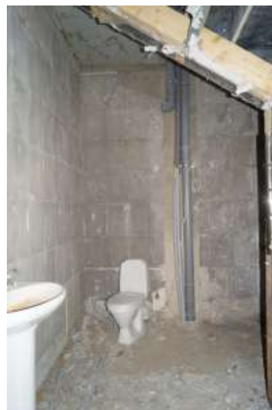
фотография №19 Санузел (№7 на поэтажном плане 1-го этажа)
