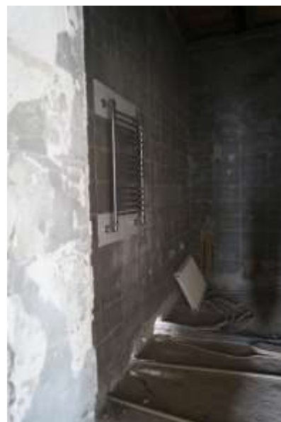
фотография №26 Санузел (№10 на поэтажном плане 2-го этажа)
