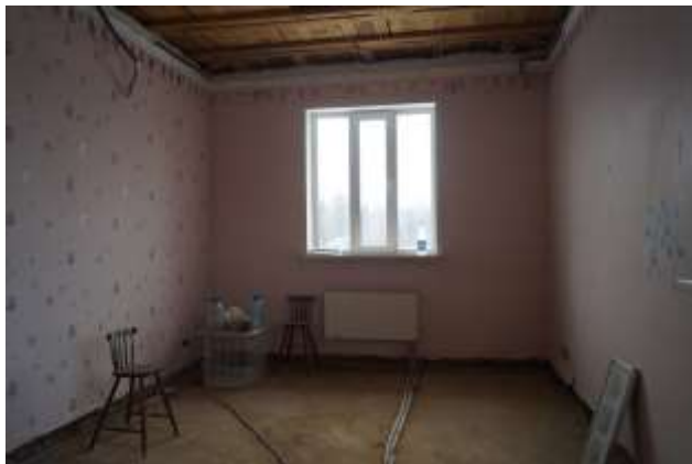
фотография №24 Жилая (№9 на поэтажном плане 2-го этажа)
