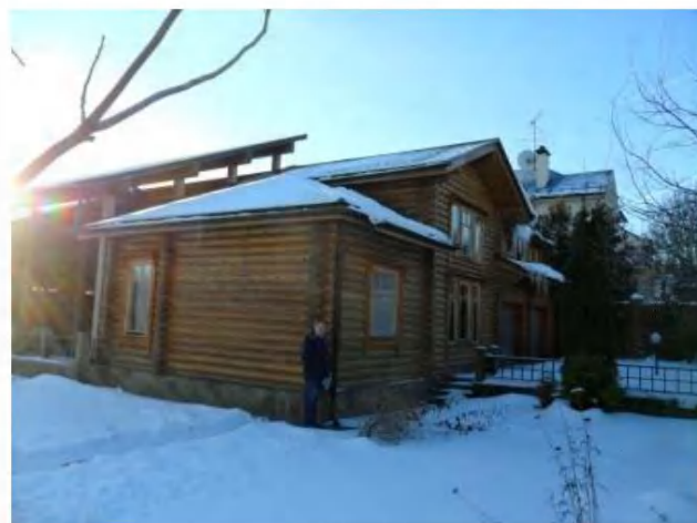
Фотография 2. Внешний вид (вид 2)
