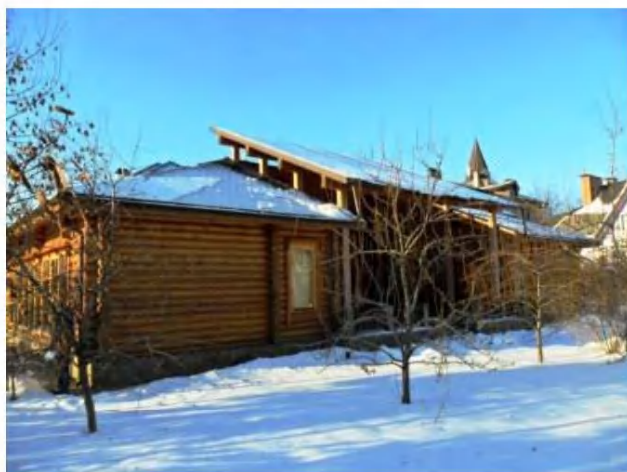
Фотография 1. Внешний вид (вид 1)
