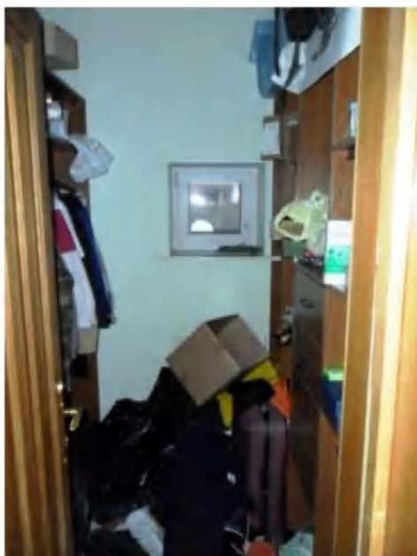
Фотография 11. Кладовая. Помещение 5 по плану БТИ
