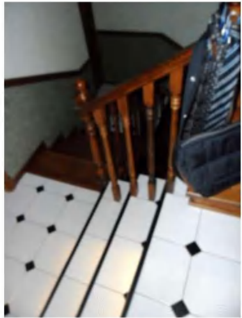
Фотография 14. Лестница в подвал
