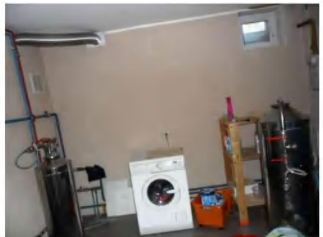
Фотография 26. Бойлерная. Помещение 15 по плану БТИ (вид 1)
