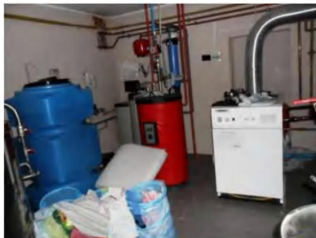
Фотография 25. Бойлерная. Помещение 15 по плану БТИ (вид 1)
