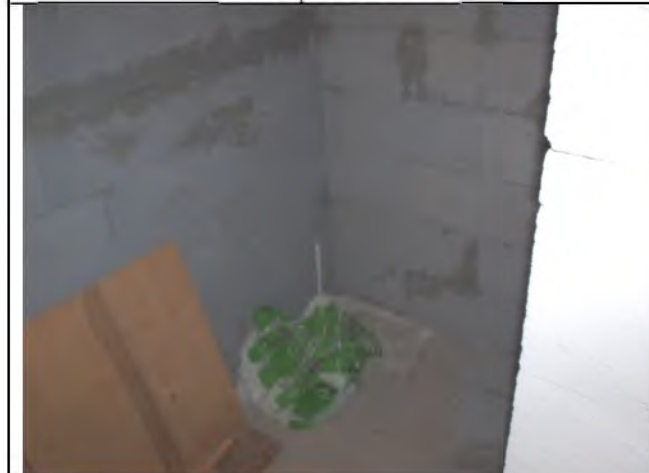
Здание спального корпуса площадью 596 кв. – помещение 2 этажа
