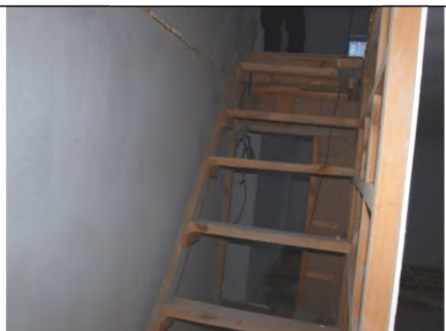
Здание спального корпуса площадью 596 кв. – междуэтажная лестница между 1 и 2 этажами
