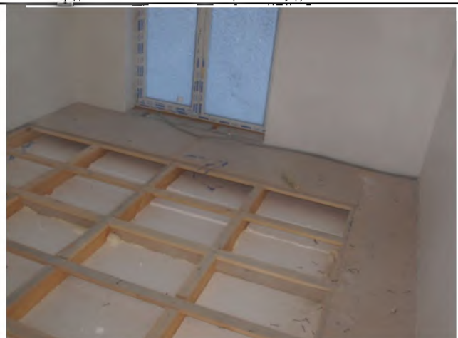
Здание спального корпуса площадью 596 кв. – помещение 2 этажа
