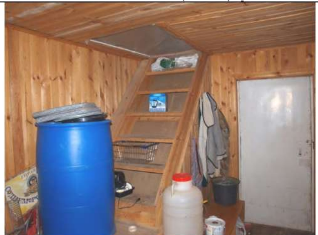
Здание площадью 206,6 кв.м., междуэтажная лестница между 1 этажом и мансардой
