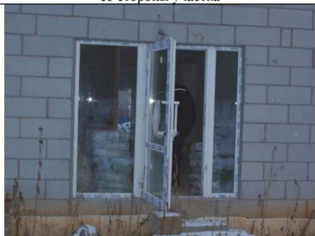
Здание спального корпуса площадью 596 кв. – вход в здание
