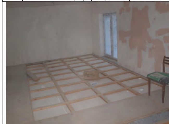
Здание спального корпуса площадью 596 кв. – помещение 2 этажа
