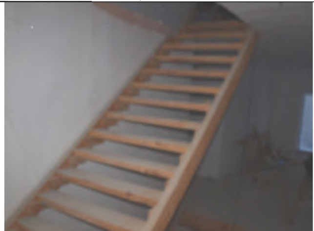
Здание спального корпуса площадью 596 кв. – междуэтажная лестница между 2 и 3 этажами
