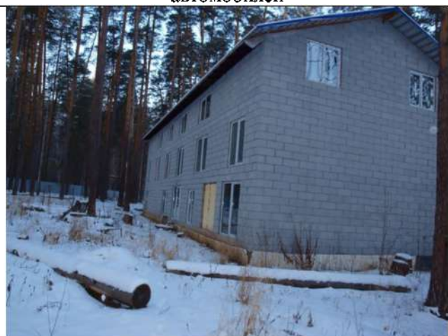
Здание спального корпуса площадью 596 кв. – вид со стороны участка
