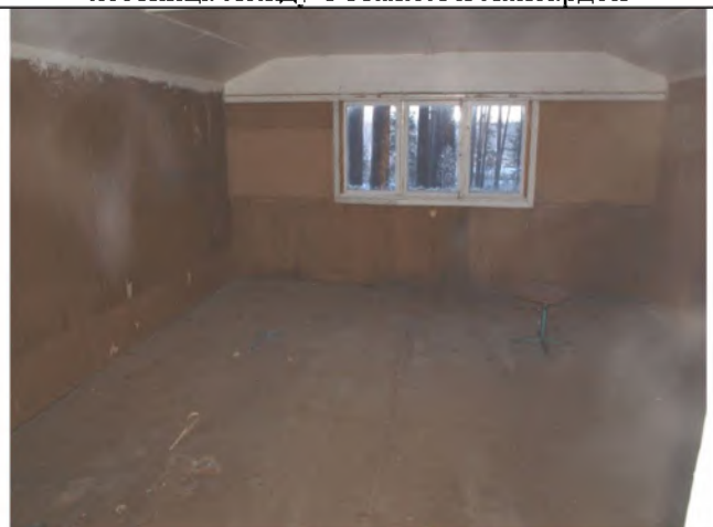
Здание площадью 206,6 кв.м., помещение мансарды
