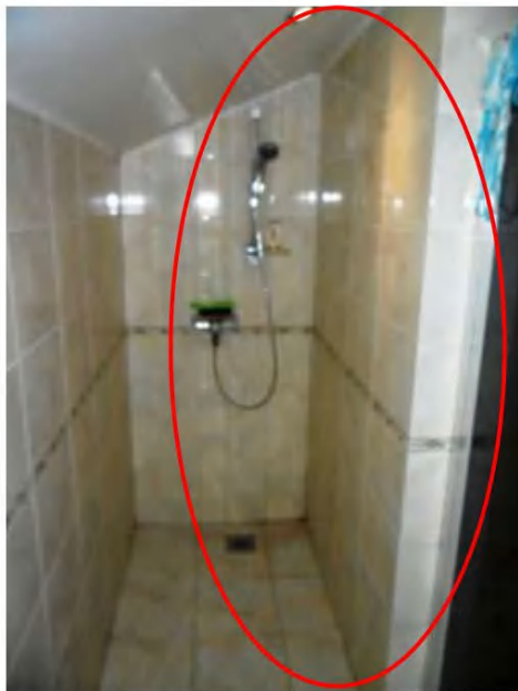
Фотография 15 Душевая, Помещение 8 по плану БТИ (вид 2) ЭЛЕМЕНТЫ ПЕРЕОБОРУДОВАНИЯ И ПЕРЕПЛАНИРОВКИ
