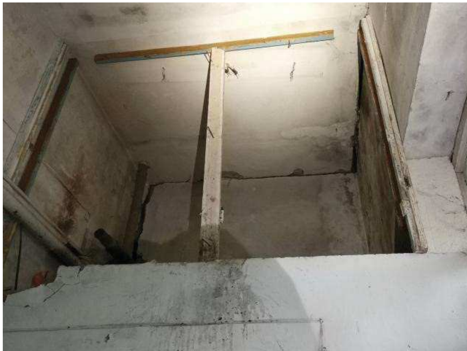
18. Объект культурного наследия «Гостиный двор», по адресу: г. Новая Ладога, ул. Карла Маркса, д.29, литера А Интерьеры. Помещение мансарды Съемка: 20.06.18.
