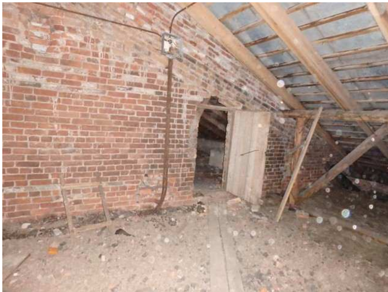
19. Объект культурного наследия «Гостиный двор», по адресу: г. Новая Ладога, ул. Карла Маркса, д.29, литера А Интерьеры. Помещение мансарды Съемка: 20.06.18.
