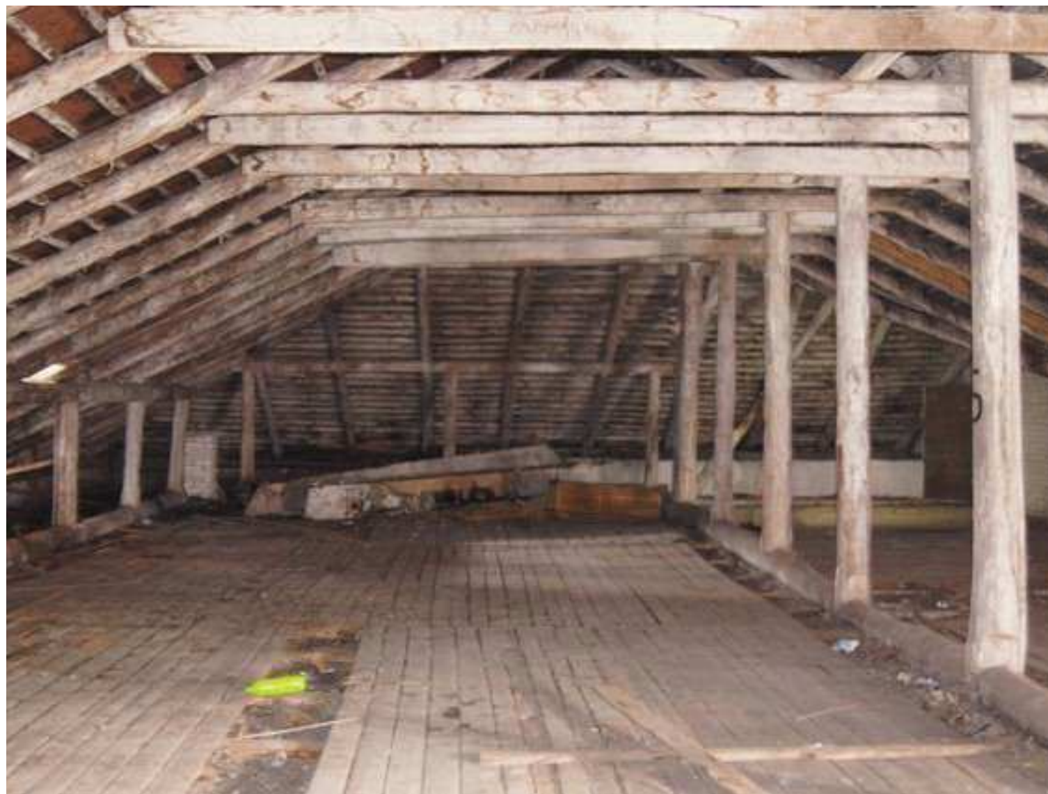
17. Объект культурного наследия «Гостиный двор», по адресу: г. Новая Ладога, ул. Карла Маркса, д.29, литера А Интерьеры. Помещение мансарды Съемка: 20.06.18.
