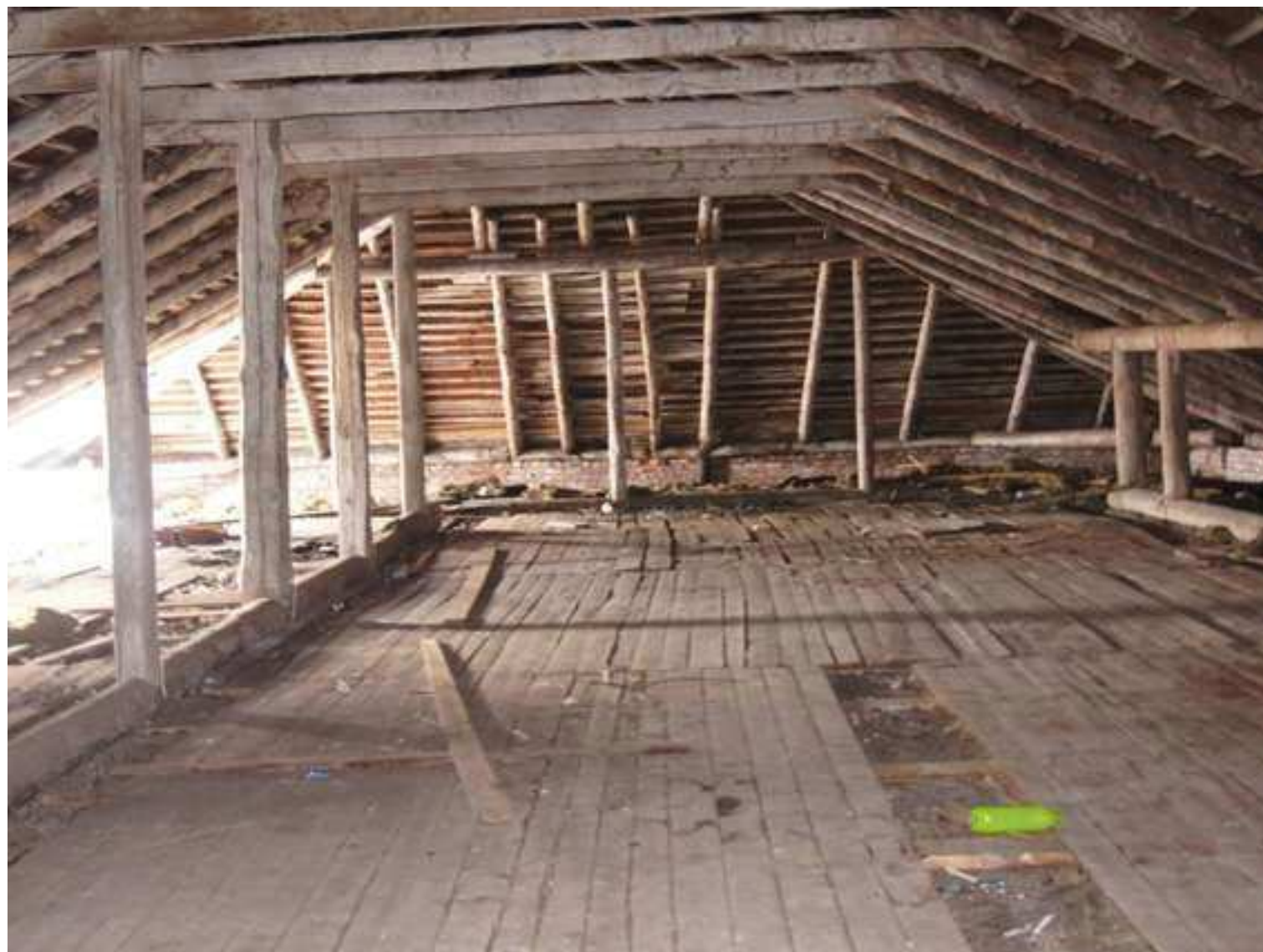
16. Объект культурного наследия «Гостиный двор», по адресу: г. Новая Ладога, ул. Карла Маркса, д.29, литера А Интерьеры. Помещение мансарды Съемка: 20.06.18.
