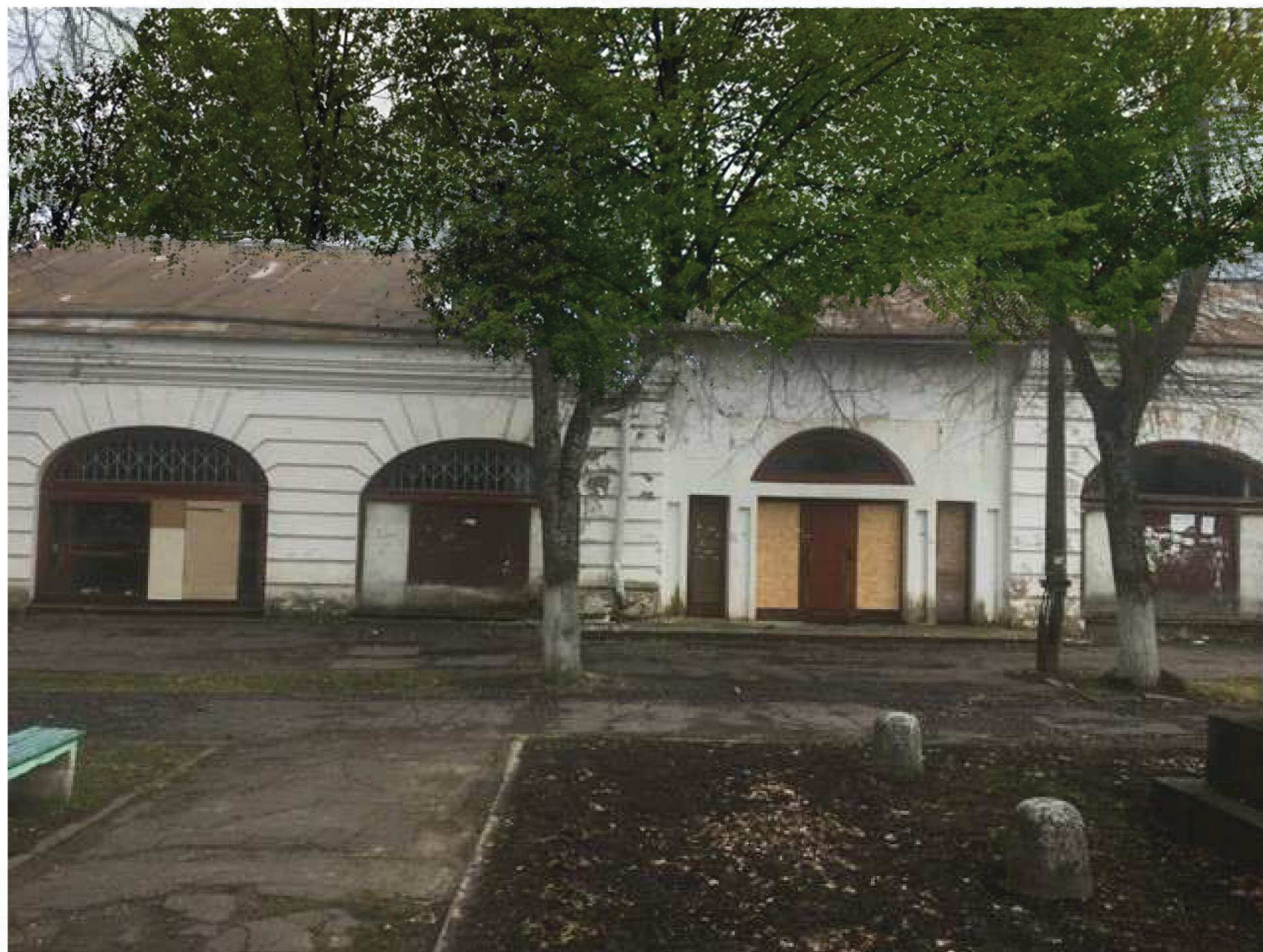
7. Объект культурного наследия «Гостиный двор», по адресу: г. Новая Ладога, ул. Карла Маркса, д.29, литера А Вид на фасад с северо-запада Съемка: 20.06.18.
