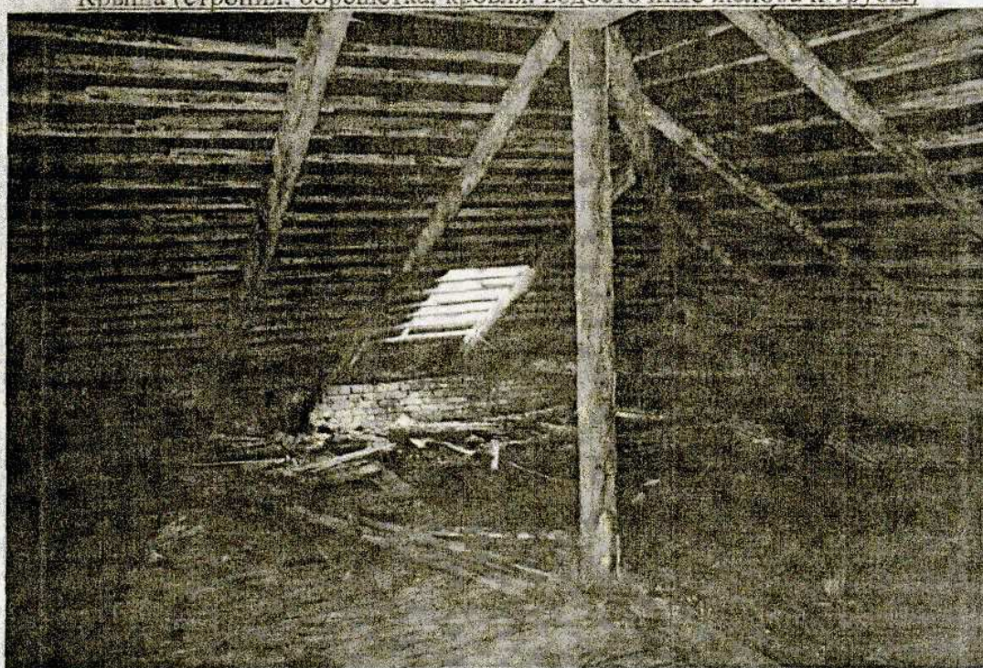
Крыша (стропил, обрешетка, кровля, водосточные желоба и трубы)
