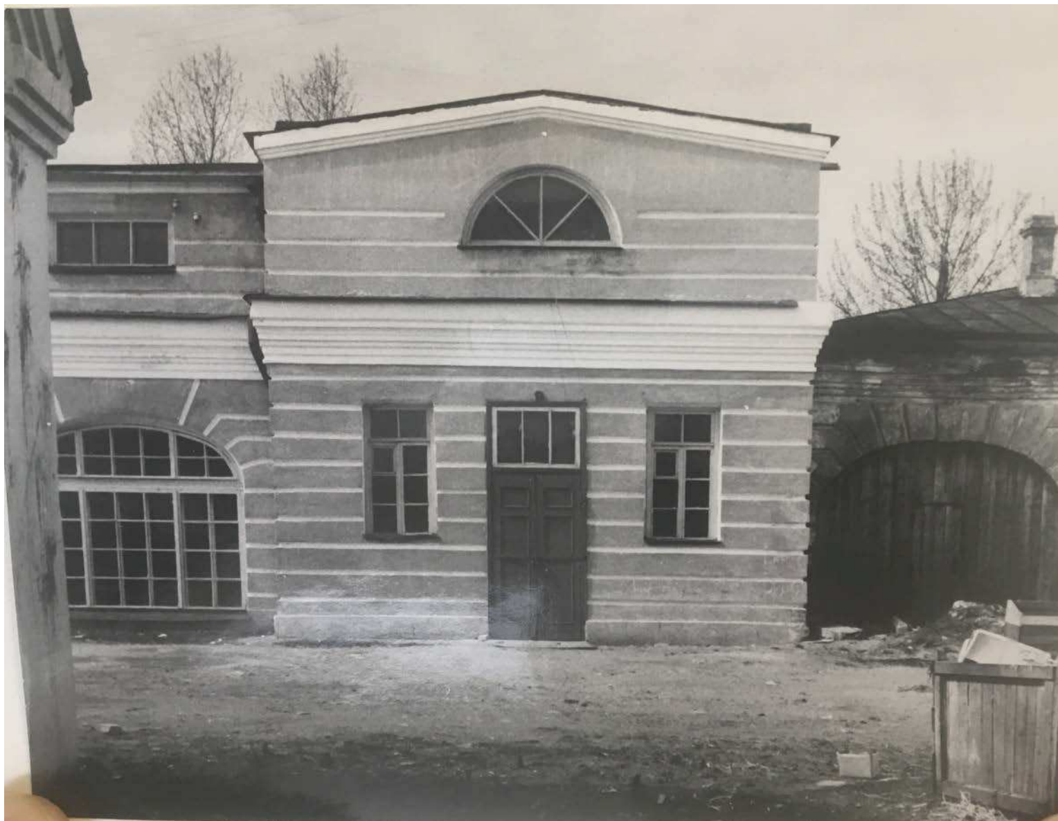
21. Гостиный двор в Новой Ладогe. Правое крыло. Новый ризалит. 1973 г.
