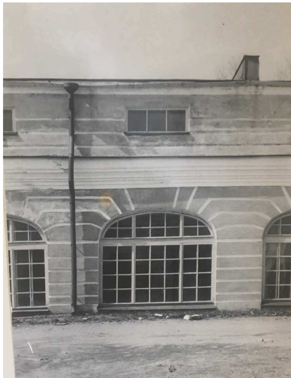
22. Гостиный двор в Новой Ладоге. Правое крыло. Дворовый фасад. 1973 г.
