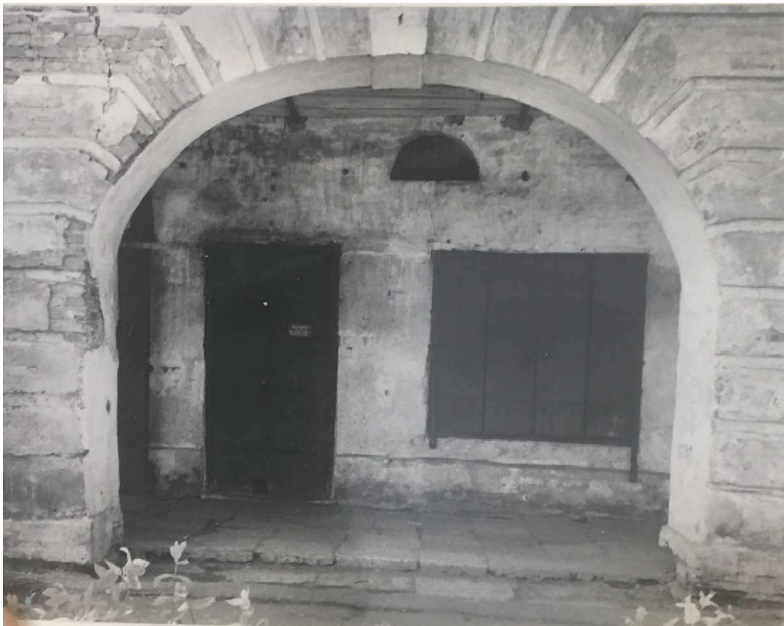
11. Арка северного фасада до реставрации 1973 г.
