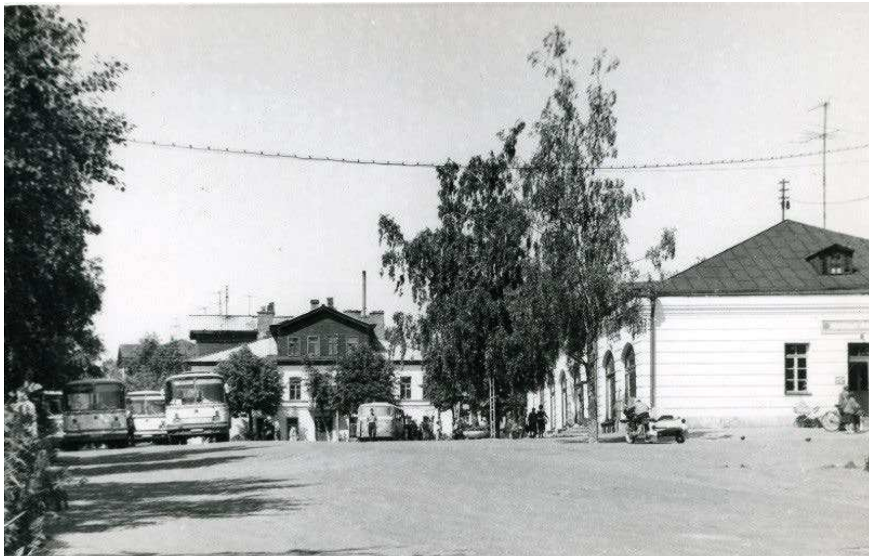
24. Автобусная станция в Новой Ладоге. 1980-е гг.
