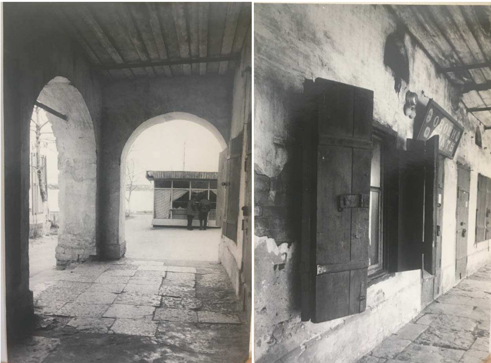
10. Северная аркада до реставрации 1973 г.
