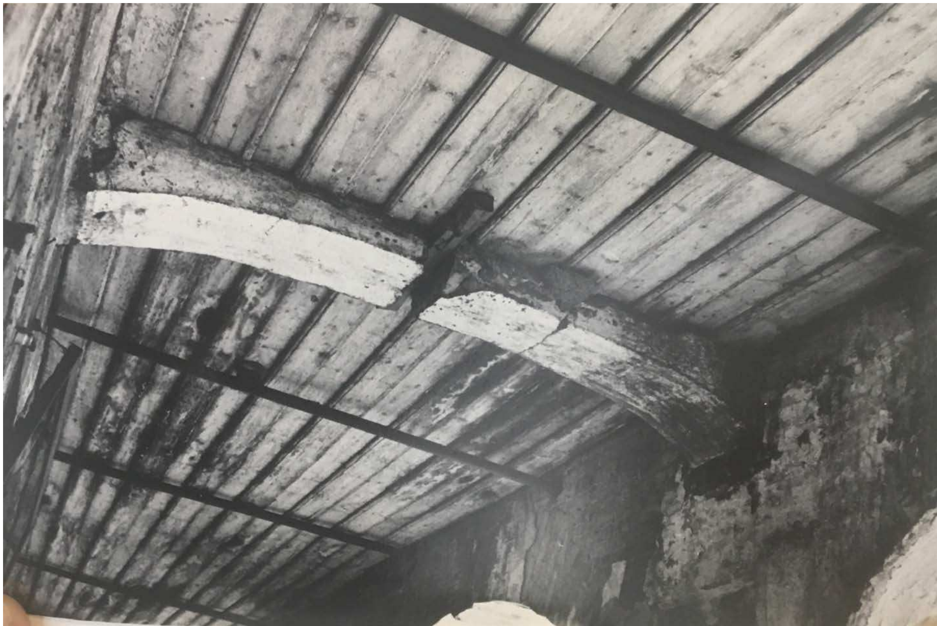
13. Деталь перекрытия аркады до реставрации 1973 г.
