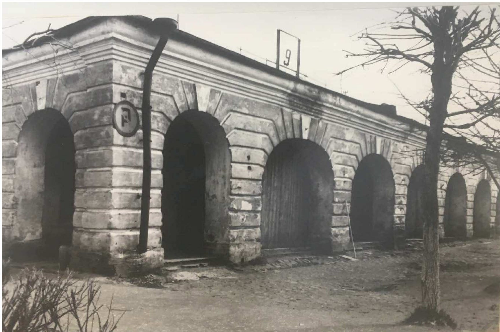
9. Фасад левого крыла до реставрации 1973 г.
