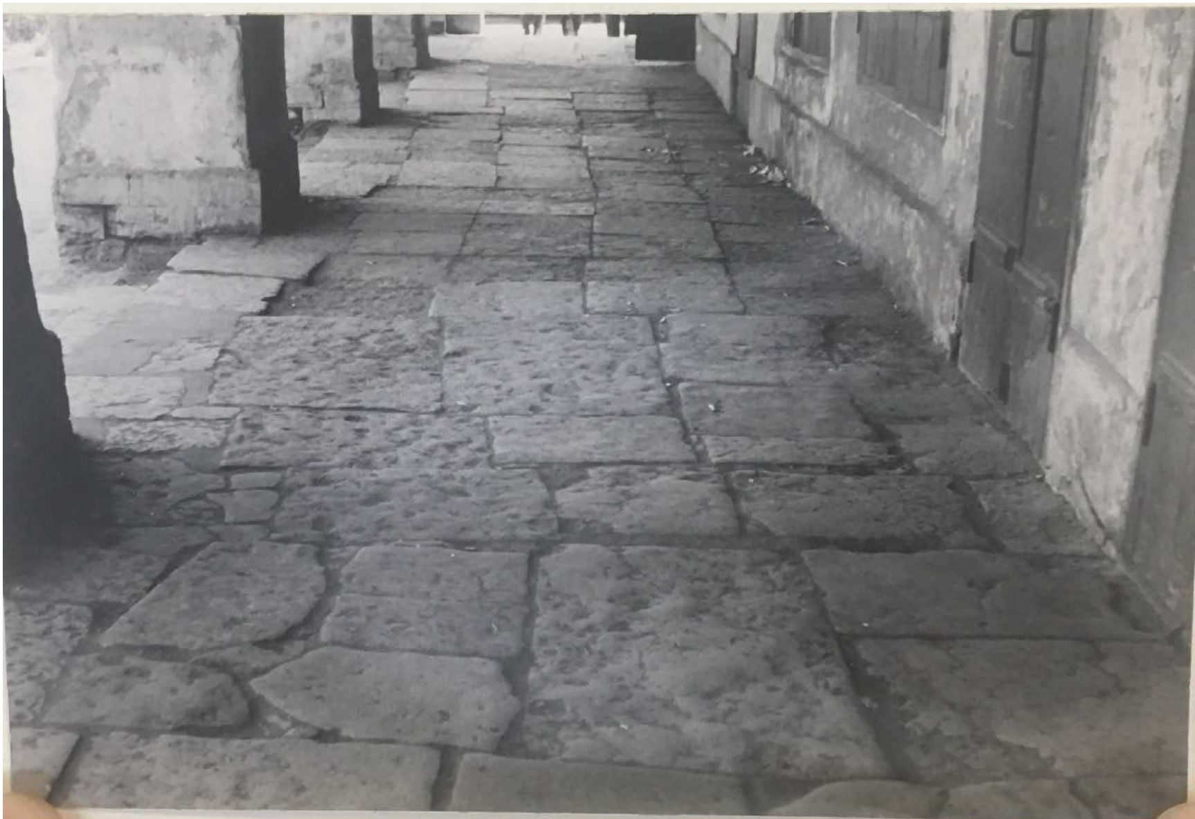
12. Аркада северного фасада до реставрации 1973 г.
